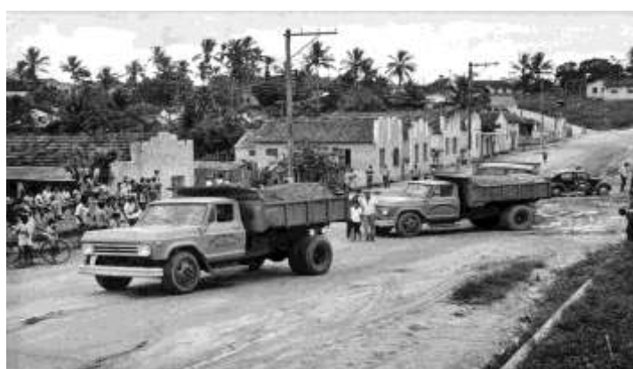
Fotografia 10: Construção do Mercado Municipal em 1967. Fonte: NARDOTO 22 (1997)
