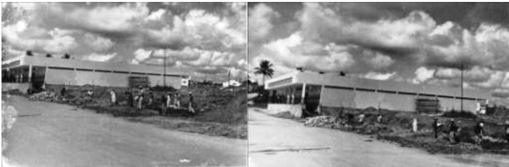
Fotografia 9: Construção da 1ª etapa do Mercado Municipal Fonte: NARDOTO (1997)
